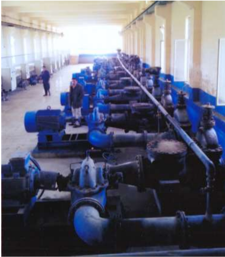
شكل (21) مضخات الدفع في مشروع ماء الخالص الجديد
