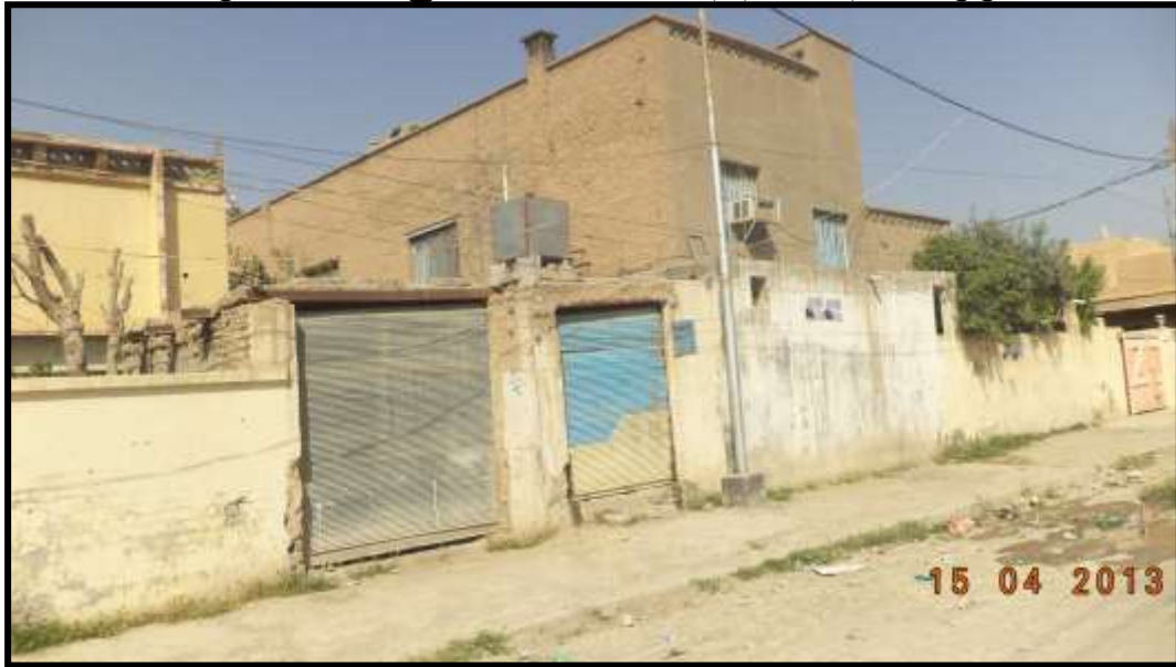
الصورة (٤٤) الطرز البنائية التقليدية / محلة ١٠٦ في منطقة الدراسة
