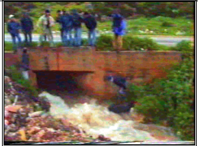
صوره (6): مخرج عبارة رافد حي الفاتح وأبو الدورين في أعالي محطة التنقية في الغريقة، فريق العمل، جامعة عمر المختار، قسم الجغرافيا، 27.03.1998 الساعة 09:45، التصريف 911 ل/ثا.
